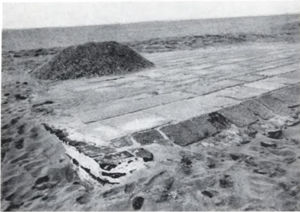
FIG. 19. — Bateria de la Costa llamada Del Medio
