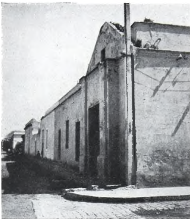
FIG. 26. -- Cuartel de Dragones. Capillas. Costado Sur.
