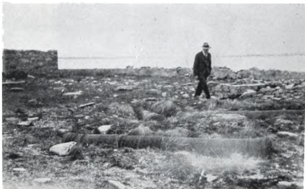
FIG. 35. — Isla de Gorríti. Batería de la Boca Chica
