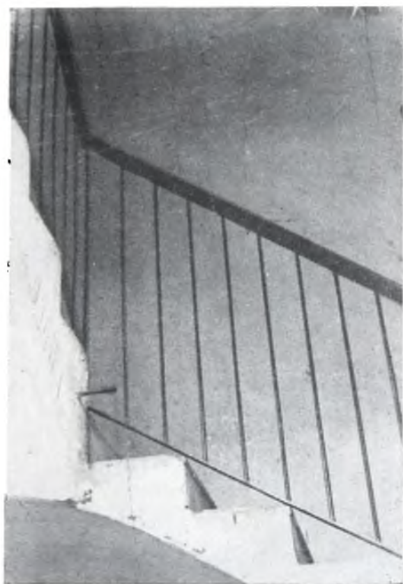
FIG. 55. — Escalera de las Torres de la Iglesia
