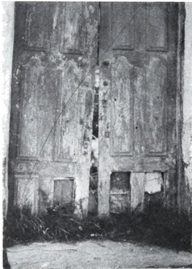
FIG. 66. — Casa de los oficiales. Puerta
