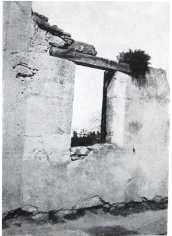
FIG. 31. — Cuartel de Dragones. Ventana.
