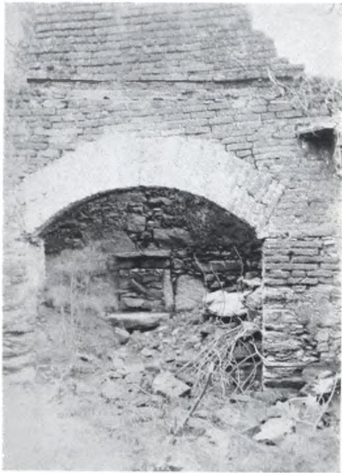
FIG. 32. — Cuartel de Dragones, Cocina.
