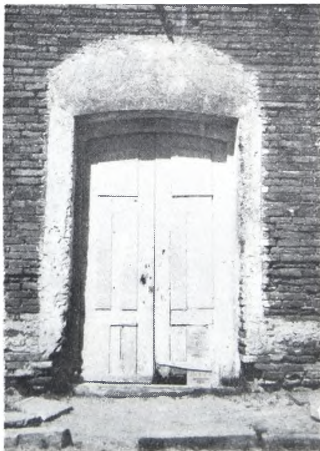
FIG. 61. Puerta de Entrada, Casa de Popham
