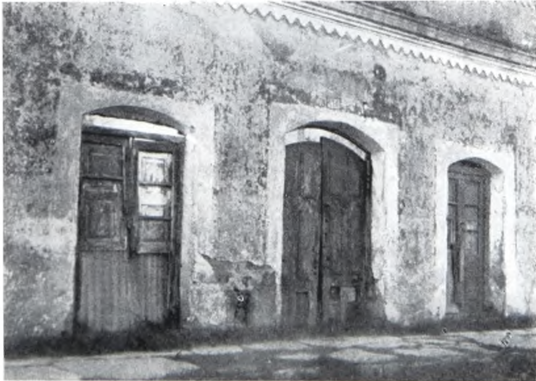
FIG. 65. -- Casa de los oficiales. Entrada
